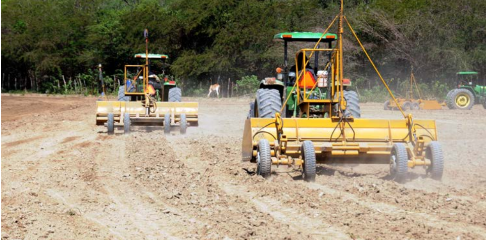
Nivelación de terreno para siembra de habichuelas. OIRSA octubre 2021.
