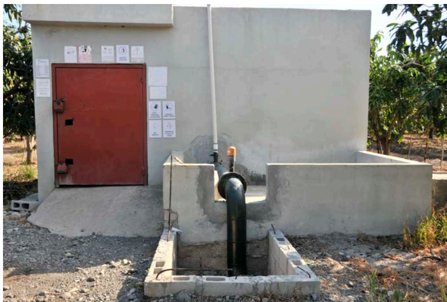
Bomba vertical de extracción de agua para irrigar plantación de mango. OIRSA octubre 2021.
